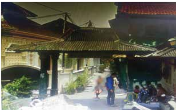
Gambar 24 Sebelum Renovasi Gapura Masjid
